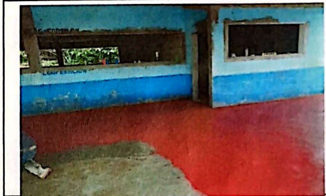
Foto 4: Colocacion de pisos
