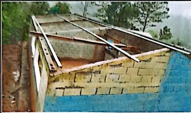
Foto 1: En mero Cambio del techado del establecimiento
