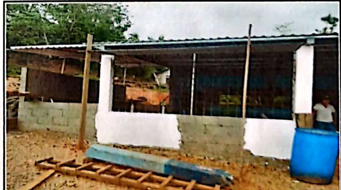
Foto 6: Colocacion de Muros: Mejoraremos el muro Perimetral.
