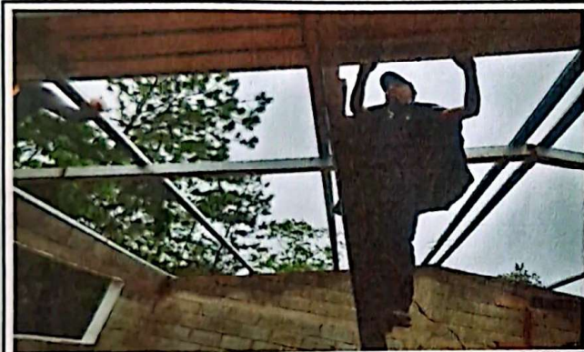
Foto 3: Sustitucion de Vigas y Costaneras.
